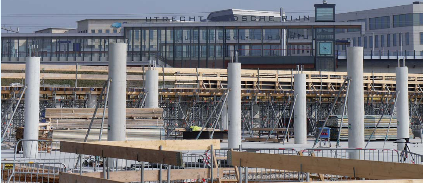
Die Baustelle des „Leidsche Rijn Centrums“ in Utrecht.
