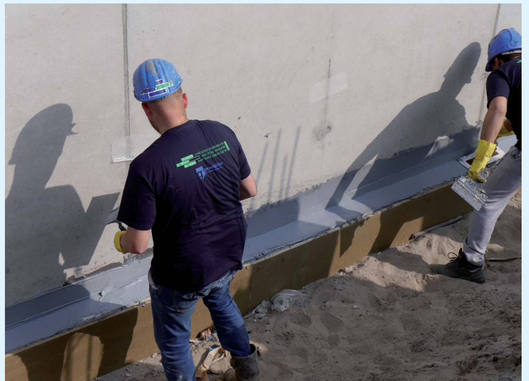
Herstellung der Dichtungskehle.
